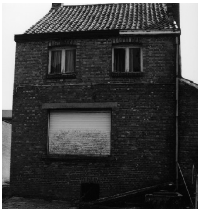
Op de foto is duidelijk te zien dat de kelder half bovengronds is, bijna een 'souterrain' en het gelijkvloers een tussenverdieping is. Foto dateert van zomer 2005. Foto: R.Dillen.
