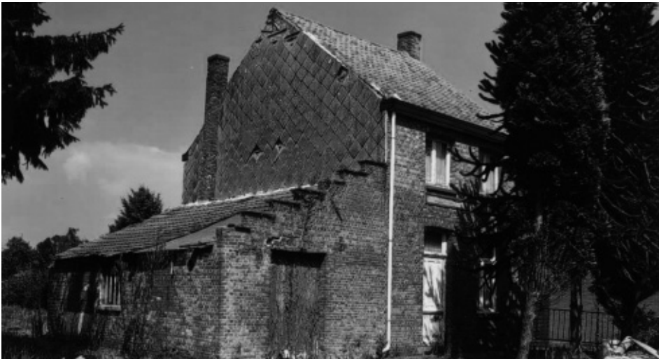
De Poederleese handmelkerij, gelegen achter de jongensschool, Kerkenend 8, ging van start in 1902 in bovenstaand gebouw. Nu wacht het gebouw de volledige sloop. Foto: R.Dillen.
